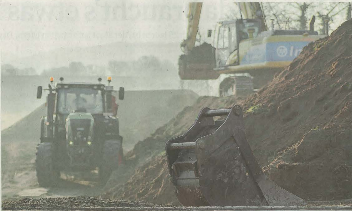
Maschinen am Aushub für die Schöfferwis-Baustelle.
